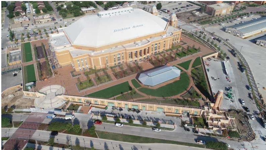
Figure 2. Le Dickies Arena à Fort Worth, au Texas, présente des événements de rodéo. Encerclant partiellement le bâtiment, le Plaza Deck est une TMP surmontée de passerelles et d'un toit végétalisé. D'une superficie de 9 290 m 2 , il sert de zone de pratique où les dresseurs peuvent s'échauffer avec leurs animaux avant les épreuves. Photo reproduite avec l'aimable autorisation de Trail Drive Management Corp et d'Owens-Corning.
