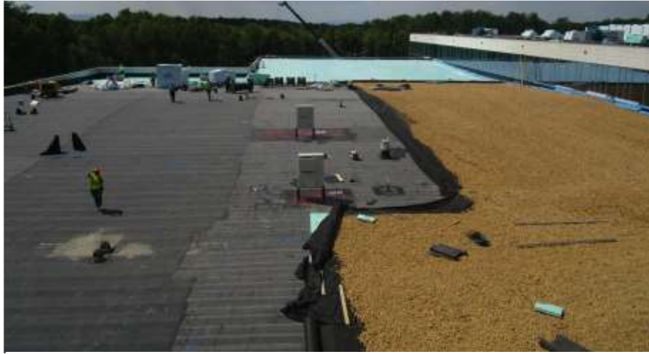
Figure 3. Une TMP de base se compose d'une membrane d'imperméabilisation, d'un isolant de PSX, d'une toile et d'un granulat de lestage. Cette TMP a été installée sur un édifice fédéral situé à Winchester, en Virginie. Le distributeur était Carlisle Coatings & Waterproofing. L'installateur, Kalkreuth Roofing & Sheet Metal. Photo reproduite avec l'aimable autorisation de Kingspan.
