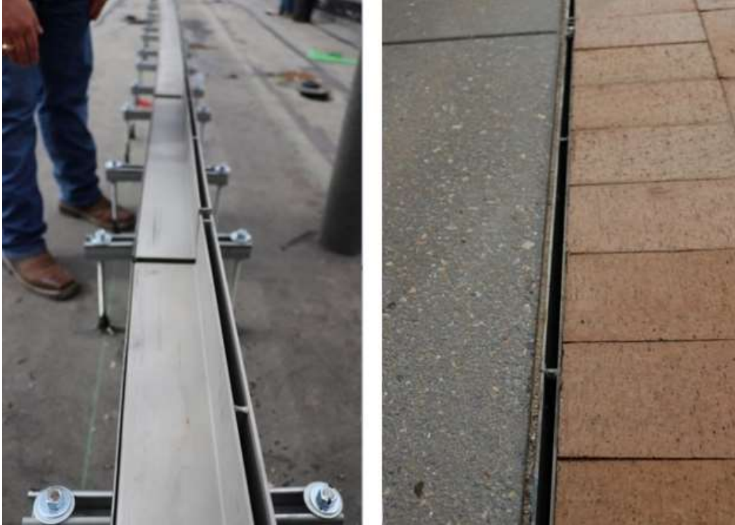
Figure 6. Des drains à fente canalisent l'eau vers un assemblage élaboré de 261 drains (à gauche). L'isolant de PSX biseauté remplit l'espace entre la membrane du toit et les drains à fente. Le drainage linéaire final prouve à quel point un drainage bien planifié peut se faire discret (à droite). Photographies reproduites avec l'aimable autorisation d'Owens Corning.
