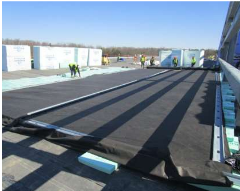
Figure 5. On recouvre la TMP de granulat peu de temps après l'installation d'une toile sur les panneaux d'isolant de PSX. Le granulat maintient non seulement l'isolant en place, mais reflète également la lumière du soleil de cette TMP, qui se trouve dans une zone où le climat est chaud et humide. Photo reproduite avec l'aimable autorisation de Kingspan.
