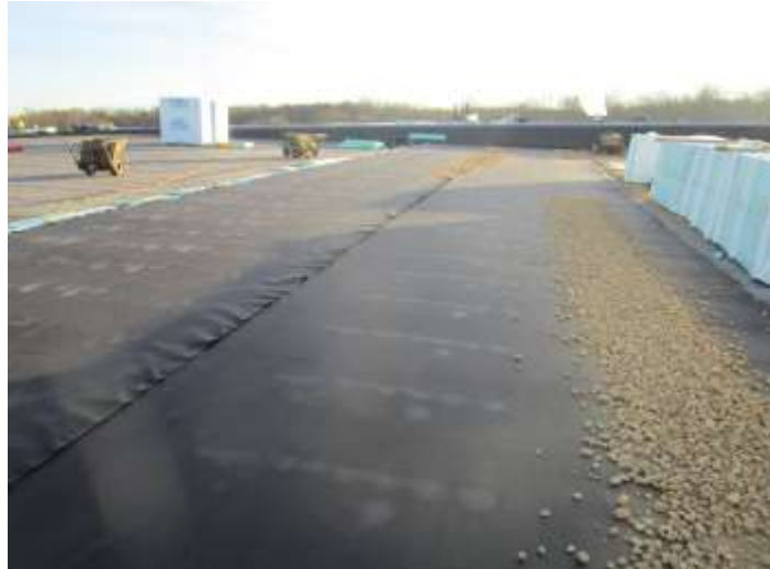
Figure 4. Le PSX de type VI avec une résistance à la compression de 40 lb/po 2 était adéquat pour la charge relativement légère sur cette TMP. Photo reproduite avec l'aimable autorisation de Kingspan.
