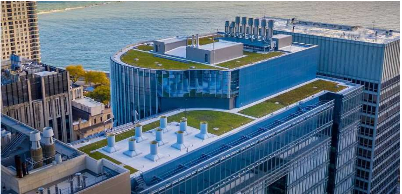
Figure 2 - Voici les 14 premiers étages d'un bâtiment proposé de 34 étages dans le centre-ville de Chicago. Les architectes ont conçu un toit bleu sur TMP pour répondre aux exigences de rétention et de stockage d'eau de leur permis de construction. La base de 14 étages répond aux exigences de gestion des eaux pluviales pour l'ensemble du bâtiment grâce à la conception de TMP bleues et vertes (végétalisées). Photo reproduite avec l'aimable autorisation d'American Hydrotech.
