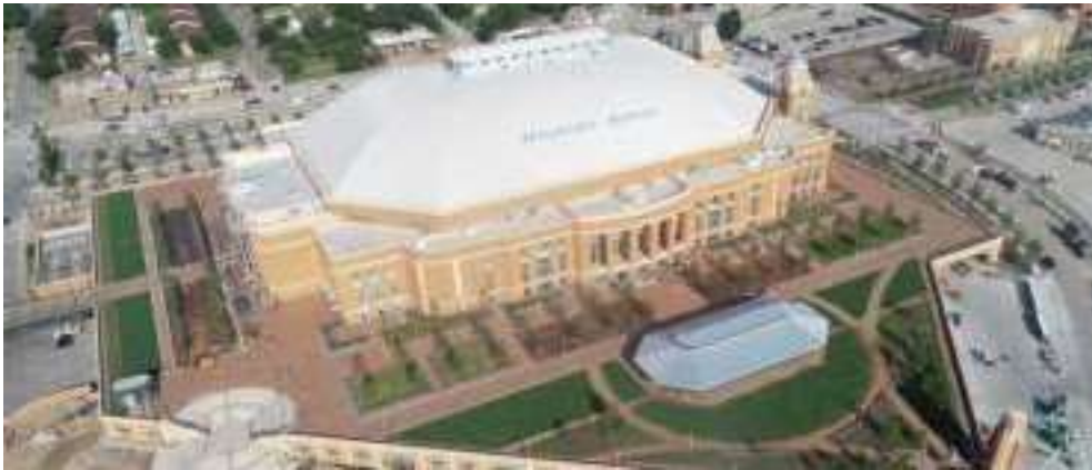
Figure 1 – Le Dickies Arena à Fort Worth, au Texas, présente des événements de rodéo. Encerclant partiellement l'aréna, le Plaza Deck est une TMP surmontée de passerelles et d'un toit végétalisé. D'une superficie de 9 290 m 2 , il sert de zone de pratique où les dresseurs peuvent s'échauffer avec leurs animaux avant les épreuves. Photo reproduite avec l'aimable autorisation de Trail Drive Management Corp et Owens-Corning.
