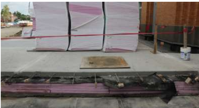
Figure 1 – L'isolant de PSX utilisé avec une configuration de dalles superposées dans un assemblage de toiture à membrane protégée sur le Dickies Arena à Fort Worth, au Texas. Notez comment la couverture de toit est protégée par l'isolant. Photographie prise pendant la construction, avec l'aimable autorisation d'Owens Corning.
