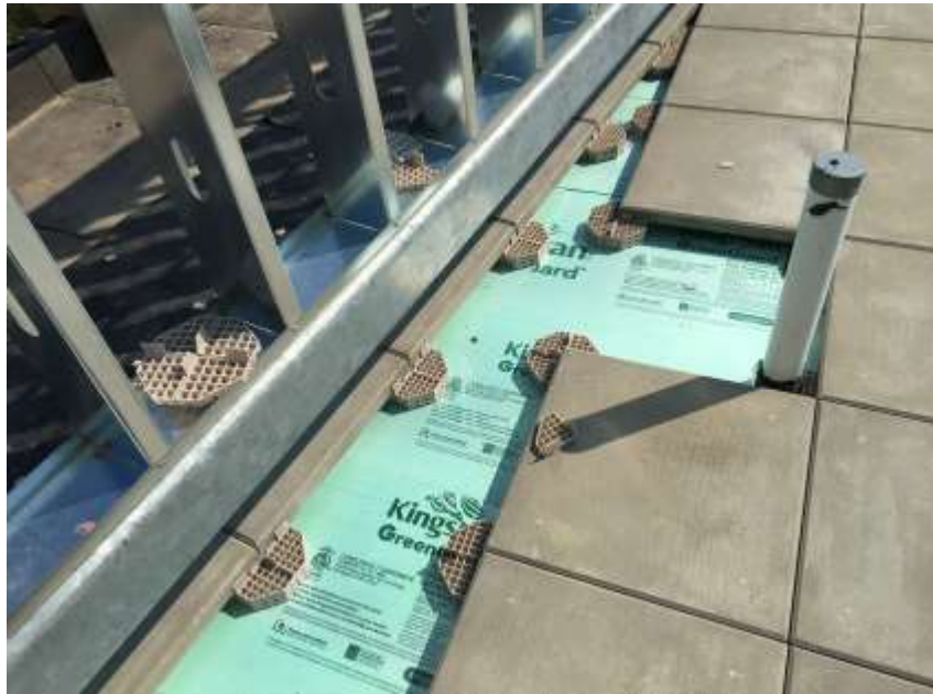
Figure 2 — Isolant de PSX utilisé dans une TMP pour un bâtiment en construction à Washington, DC. Des pavés lourds sont utilisés pour lester l'isolant de PSX. Photo reproduite avec l'aimable autorisation de Kingspan.
